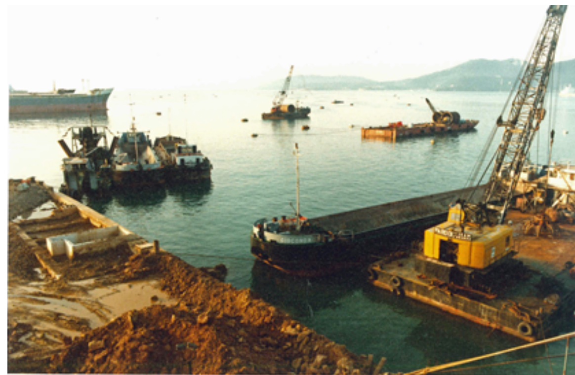
Dragaggio per istallazione di bacino galleggiante presso cantiere INMA - La Spezia
