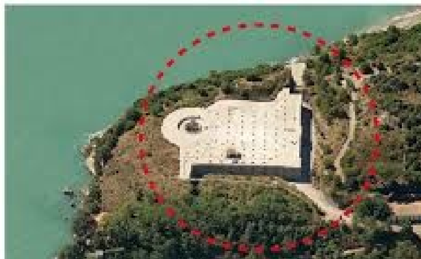
Restauro ex Batteria Umberto I Isola Palmaria - La Spezia
