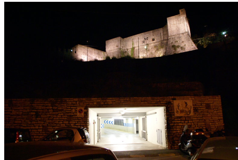
Parcheggio interrato multipiano via XX Settembre - La Spezia
