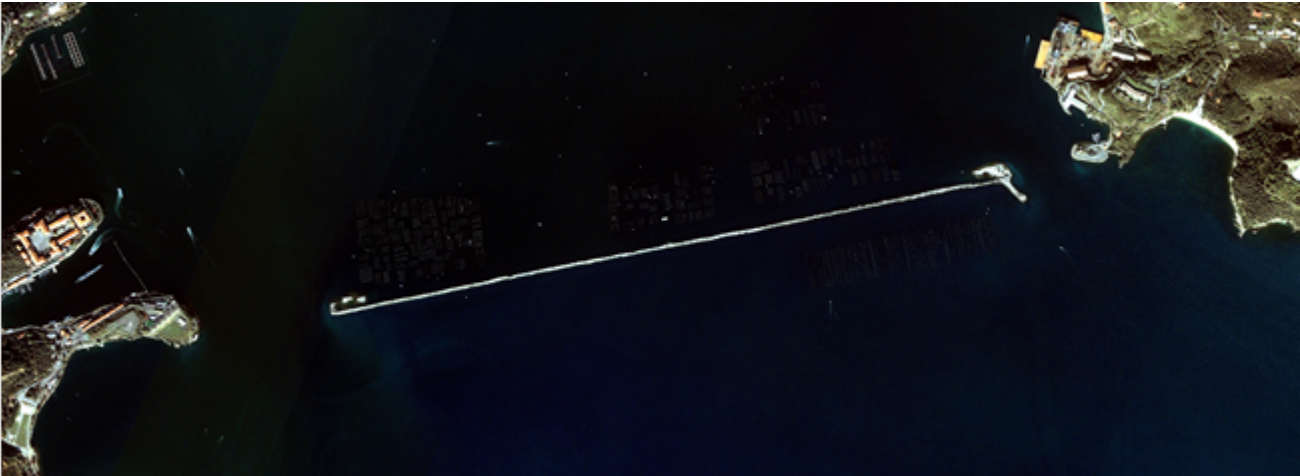
rafforzamento della diga foranea - La Spezia
