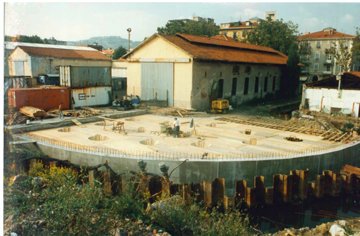
Deviazione torrente "Vecchia Dorgia e relativa copertura -La Spezia
