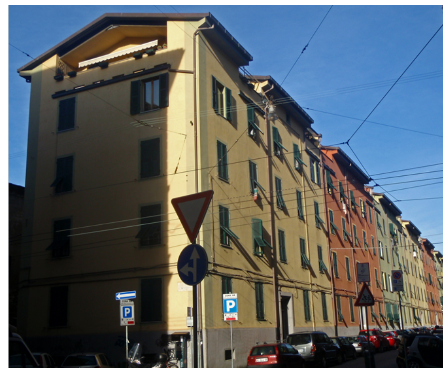
Ristrutturazione edilizia compresa realizzazione di 18 nuovi alloggi in via Napoli -La Spezia
